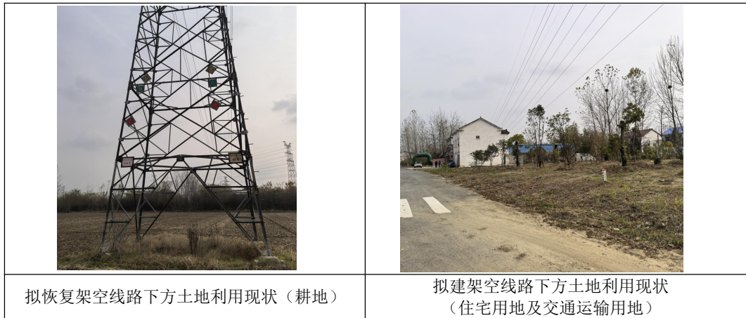
图 3-1 本项目周围环境现状照片
