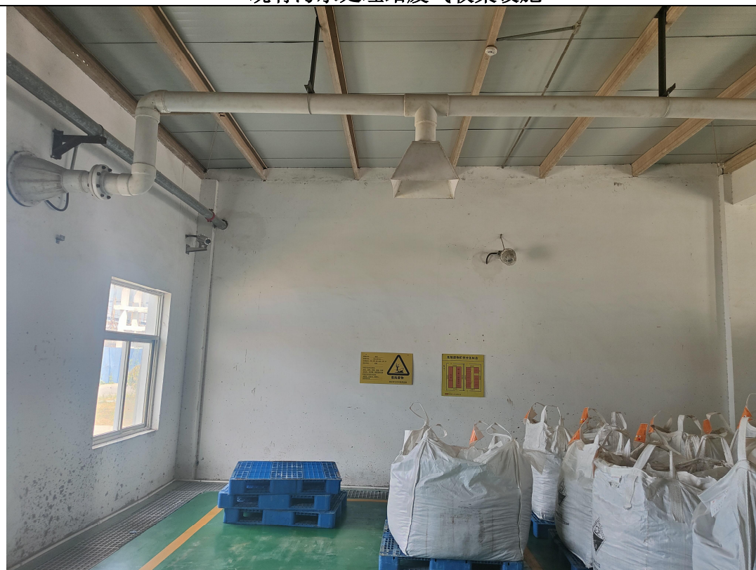
现有污水处理站废气收集设施
