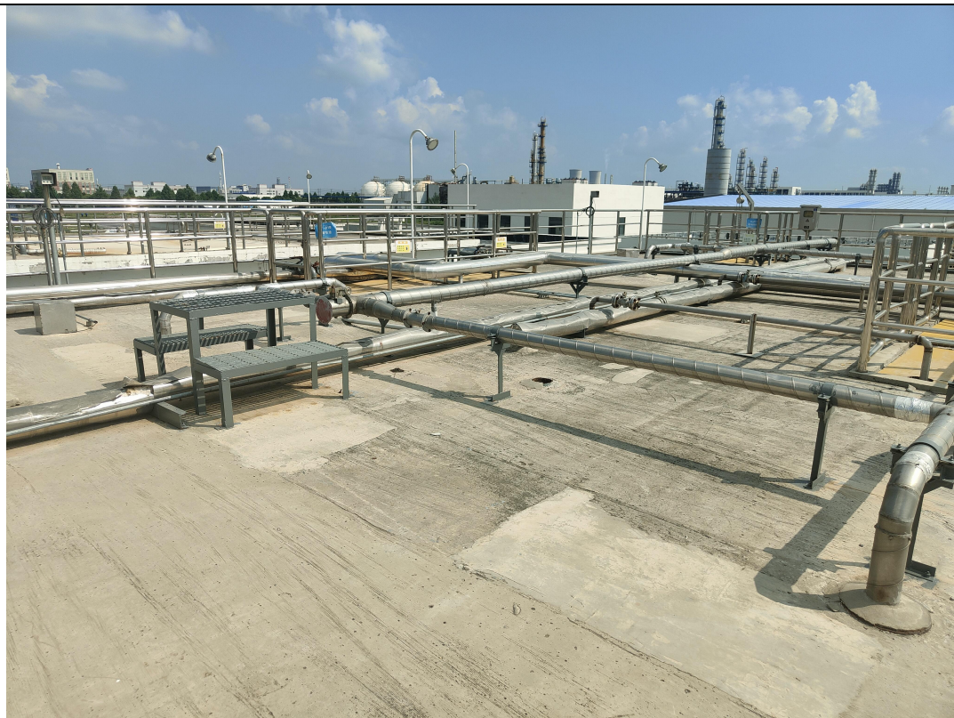
现有污水处理站废气收集设施
