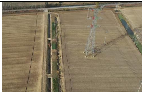
220kV 范宝 49E7/49E8 线#36 塔周边
