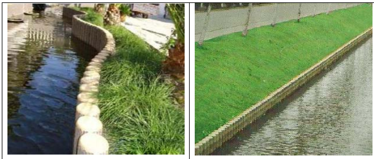
图2-14 木桩（仿木桩）护岸实景图
