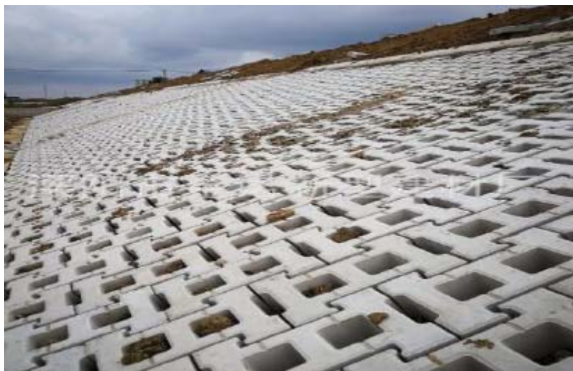
图2-13 联锁式预制砼格栅护岸实景图
