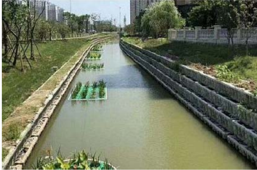
图 2-12 阶梯式生态挡墙护岸实景图
