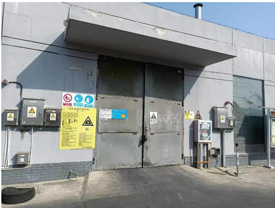
厂内现有危险废物仓库
